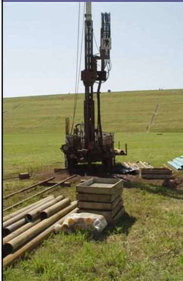
Izvedba opazovalnih objektov – piezometrov
